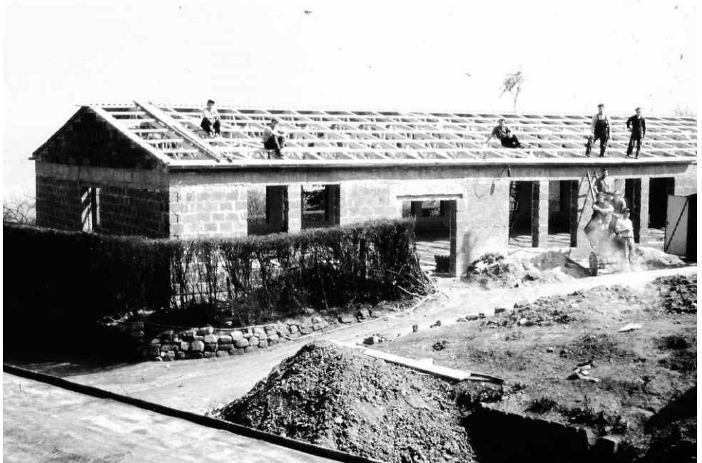
Rohbau der späteren Notkirche
